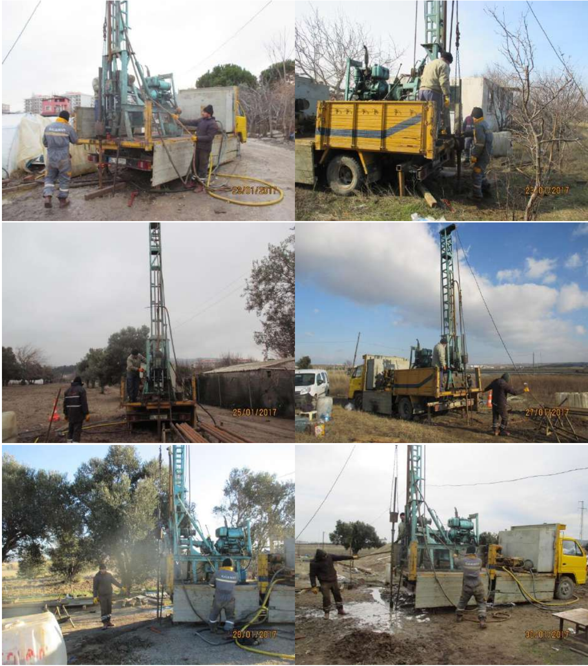
FOTOĞRAF. 1: SONDAJ ÇALIŞMALARI
